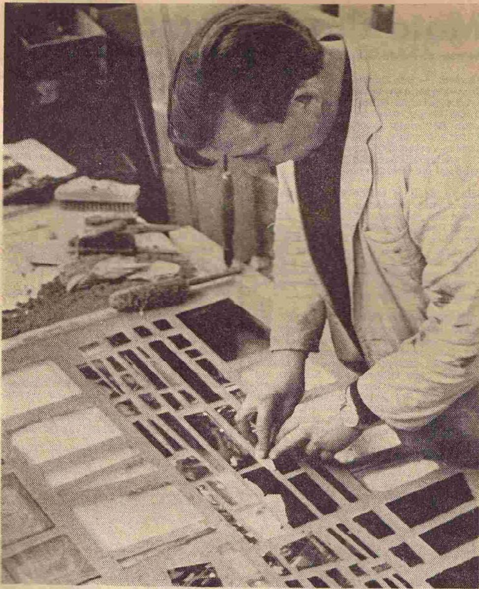
Glasmaler Peter Thomas bei der Arbeit: Im Augenblick arbeitet er an einem der neuen großen Betonglasfenster, die für die neue Friedhofshalle in Wassenberg bestimmt sind. (Foto: Patkowski)
